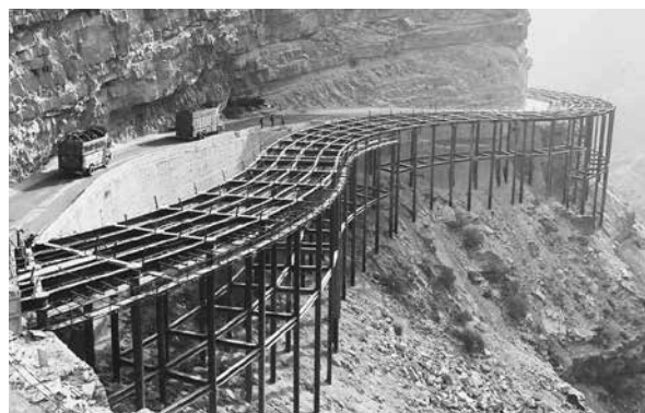
パキスタンの断崖絶壁に採用されたSqCピア工法
